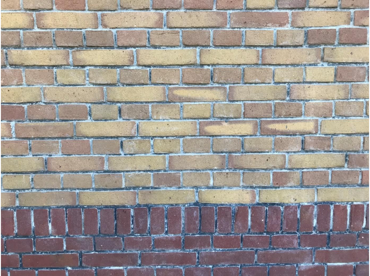
Staan verband metselwerk
